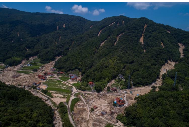
無数の土石流が発生した山（安浦町）
